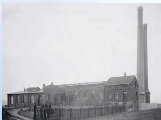
So sah das Wasserwerk der „Actiengesellschaft Oberhausener Wasserwerk“ um 1880 aus.
