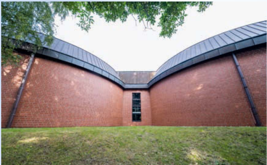
RWW-„Tatort“ Tackenberg: Hier stehen große Behälter, von denen aus das aus dem Münsterland kommende Wasser in Oberhausens Norden verteilt wird.
