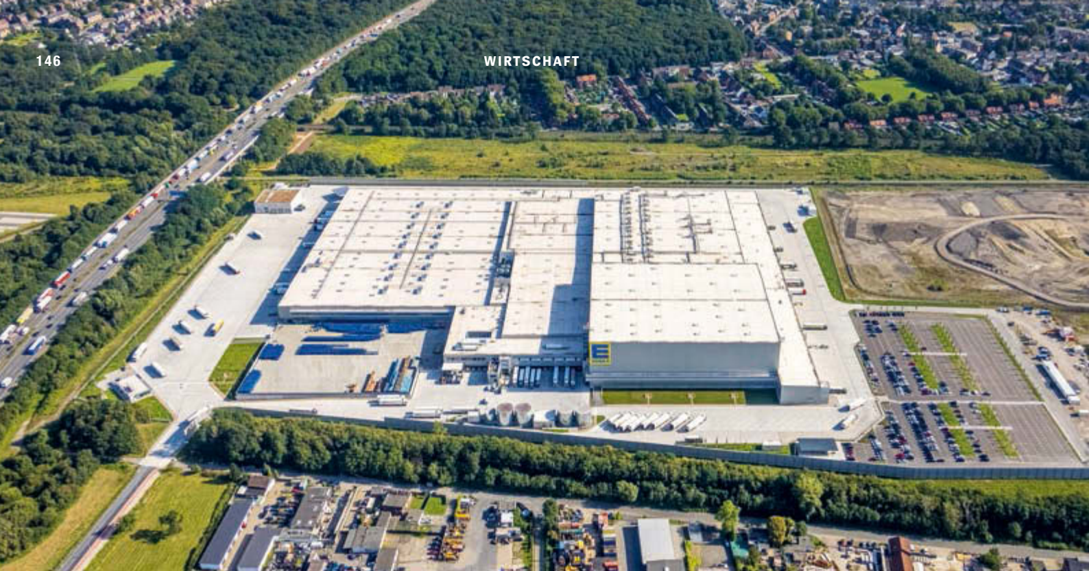
Das Edeka-Zentrallager auf dem Waldteich-Gelände mit voraussichtlich rund 1000 Arbeitsplätzen ist die größte Unternehmensansiedlung in Oberhausen in diesem Jahrhundert – und schon teilweise in Betrieb. 320 Filialen in der Region werden von hier aus beliefert.
