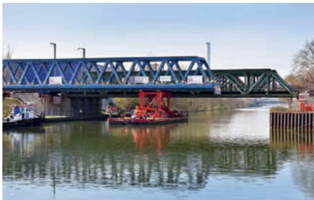
Kraftakt: Die 260 Tonnen schwere Brücke für die Betuwe-Linie wird über den Rhein-Herne-Kanal eingeschwommen
