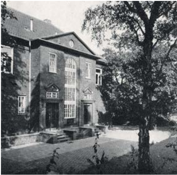
Das früher „Haus der Volkshochschule“ genannte Gebäude an der Schwartzstraße beherbergt heute das Bildungsbüro der Stadt.
