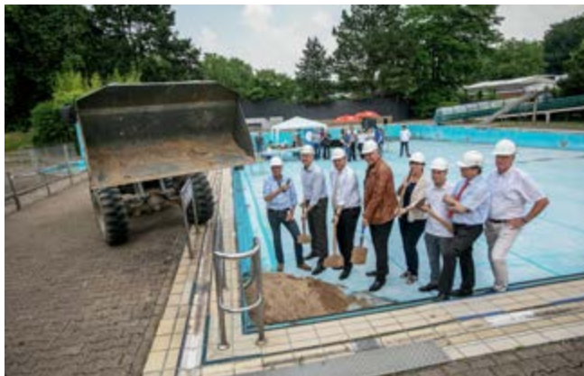
Startschuss: Ein neues Freibad für den Revierpark Vonderort
