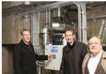
In der Barmingholtener Energieanlage (v. l.): Bernhard Homberg (Technischer Vorstand der evo) und die Mitarbeiter Andreas Overberg und Karl-Heinz Spenner.
