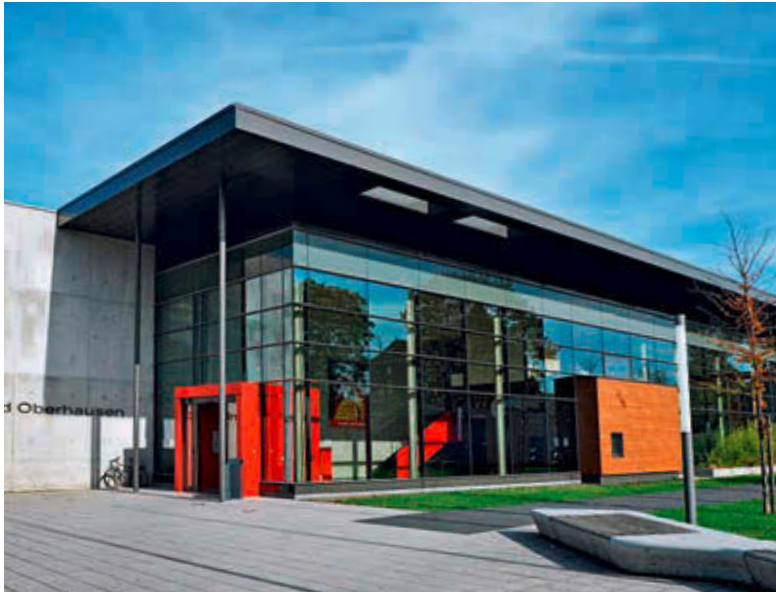
Das Hallenbad Oberhausen gehört zu den wenigen, dafür umso bemerkenswerteren, Neubauten der letzten Jahre
