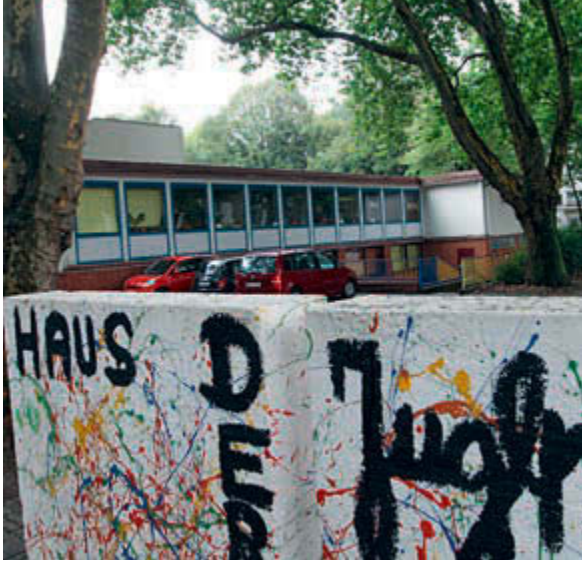
Schwere bauliche Mängel festgestellt: Dem Haus der Jugend drohte die Schließung
