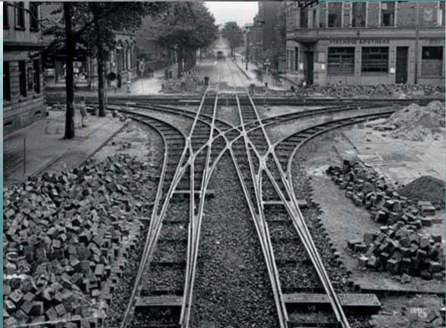
Verlegen von Weichen für die Straßenbahn an der Schwartzstraße, 22.07.1949 LVR-Industriemuseum
