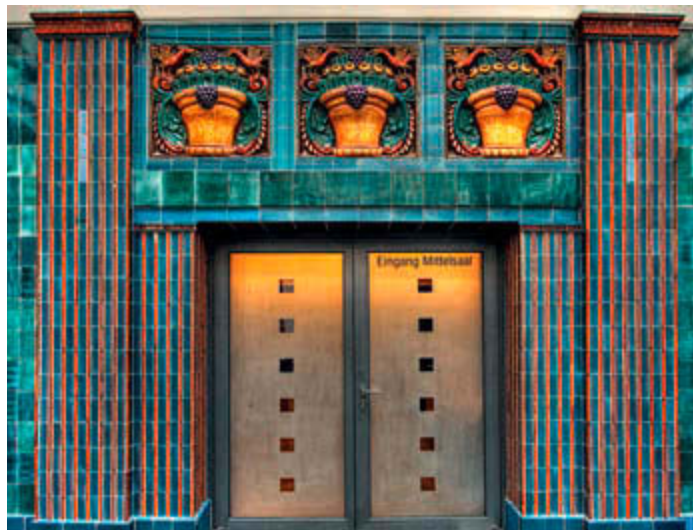
Die hochwertige Keramik an den Wänden des Eingangsbereichs wurde erst beim Umbau 1992/93 wieder freigelegt
