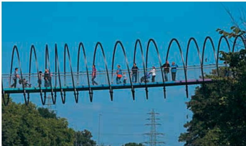
*496 Spiralen aus Aluminium umhüllen markant die 406 Meter lange Brücke*
