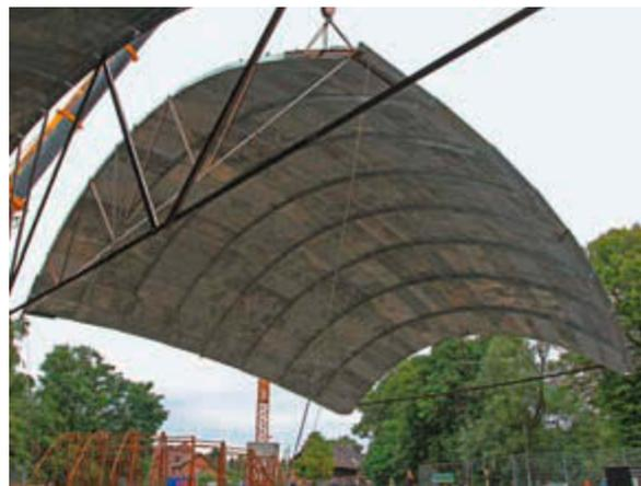
**Mit schwerem Gerät und Maßarbeit wurde das insgesamt 73 Tonnen wiegende Dach in zwei Teilen aufgesetzt**
