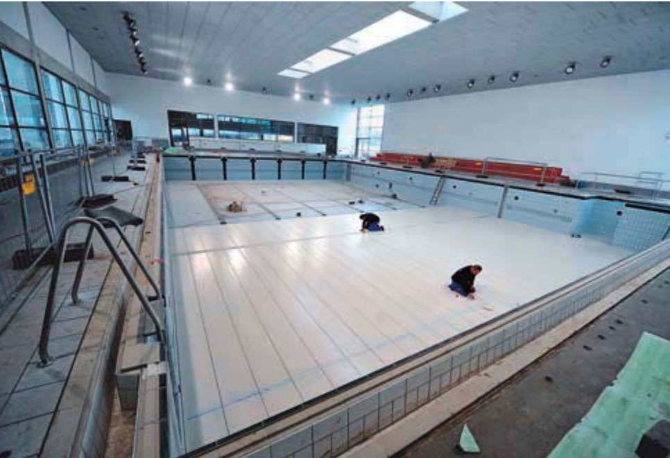
Letzte handwerkliche Arbeiten im 25-Meter-Becken für die Schul- und Vereinsschwimmer
