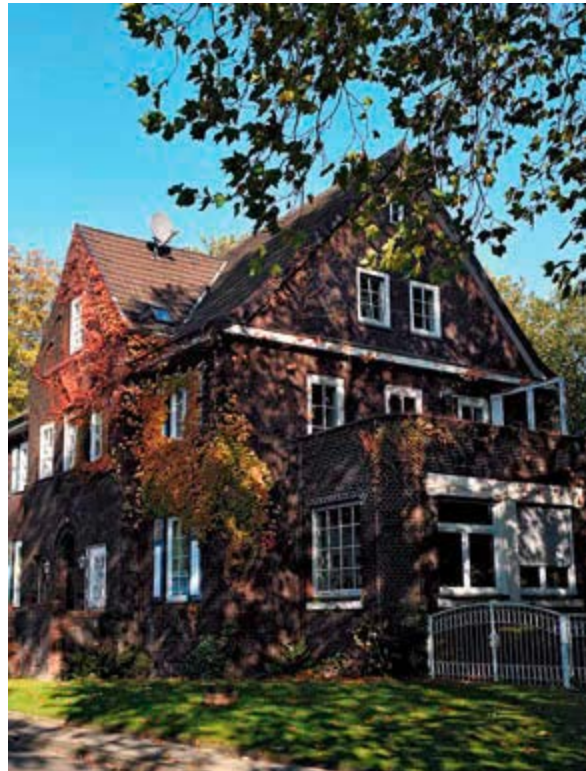
Andere Ansichten: Vier Bauphasen charakterisieren die differenzierte Architektur der nach Plänen des Berliner Architekten Bruno Möhring errichteten Häuser „Am Grafenbusch“
