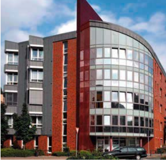
Großes Jubiläum: Das St. Josef-Hospital - hier der Neubau des Pflegezentrums an der Mülheimer Straße - wird 125 Jahre alt
