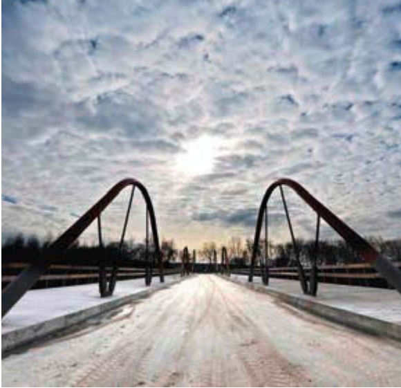
Fünf Jahre nach Sperrung des alten maroden Bauwerks eingeweiht: Die neue Ripshorster Brücke an der Stadtgrenze zu Essen
