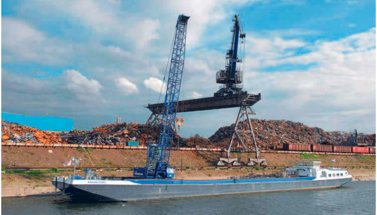
Die Schrottinsel im Ruhrorter Hafenteil ist Deutschlands größter Schrottplatz und wichtig für den Stahlstandort Nr. 1
