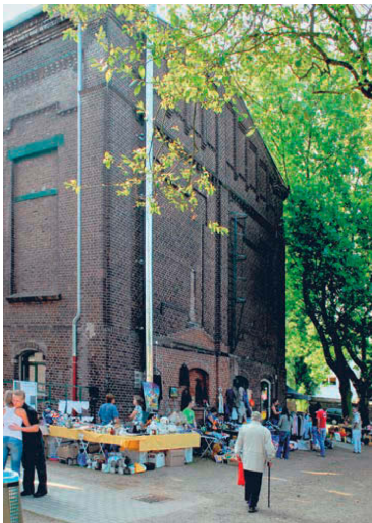
Umgeben von altem Baumbestand: Im ehemaligen Fördermaschinenhaus der Zeche Concordia spielt heute das Niebuhr-Theater
