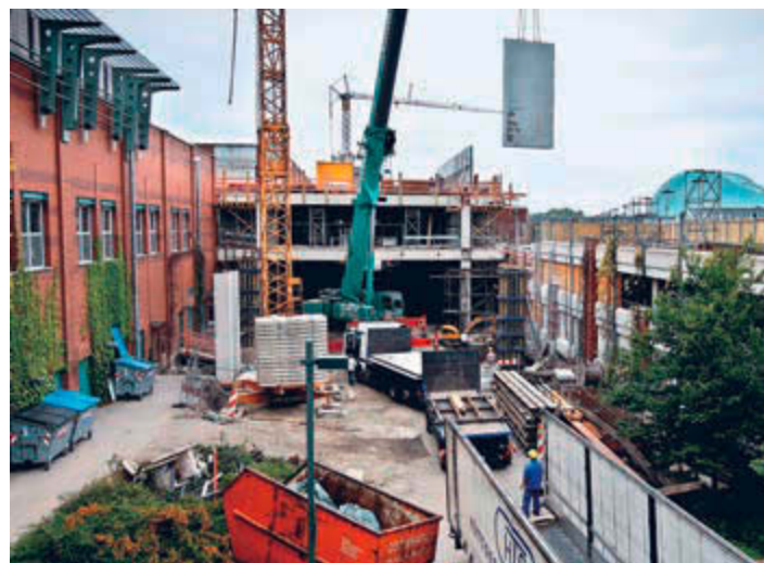
Die Galeria Kaufhof wird bereits bis Anfang 2009 um 3700 Quadratmeter geräumiger
