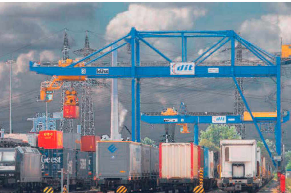
Der Hafen ist Drehscheibe zwischen Schiene, Straße und Wasserstraße
