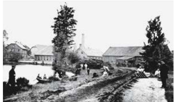
Ansichten der St. Antony-Hütte Mitte des 19. Jahrhunderts
