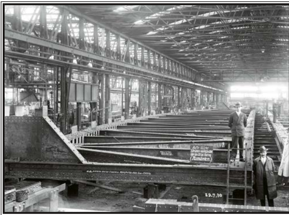
In der Brückenbauwerkstatt: Träger für ein Brückenprojekt über den Fluss Olt bei Slatina in Rumänien, 1930
