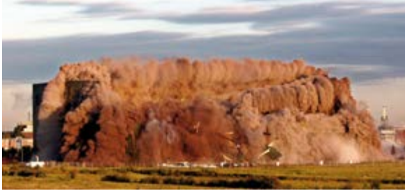
Platz schaffen für neue Ansiedlungen: Das alte Elektrostahlwerk wird gesprengt
