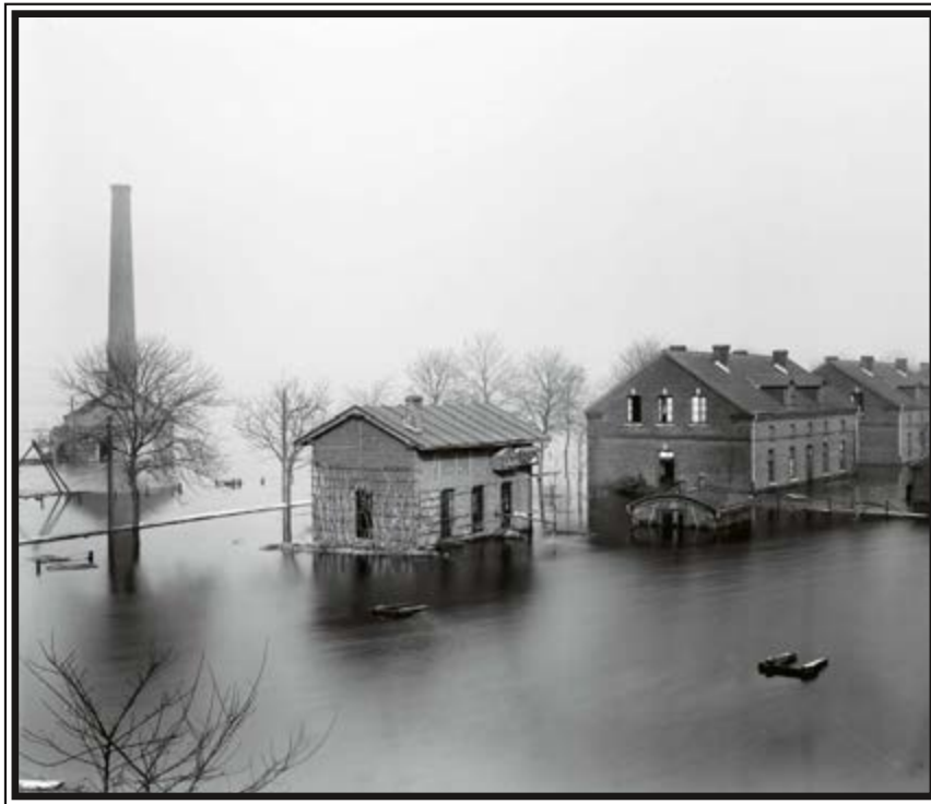
Hochwasser zwischen Waghalsbrücke und Walzwerk Neu-Oberhausen, 1909
