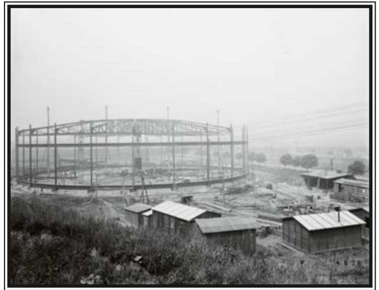
Wasserloser Gasometer am Werk Oberhausen im Bau, 1928
