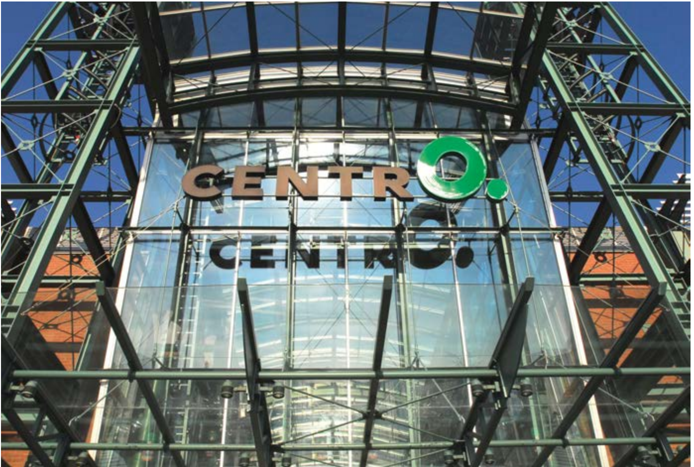
Stahl und Glas prägen die Architektur des modernen Einkaufszentrums
