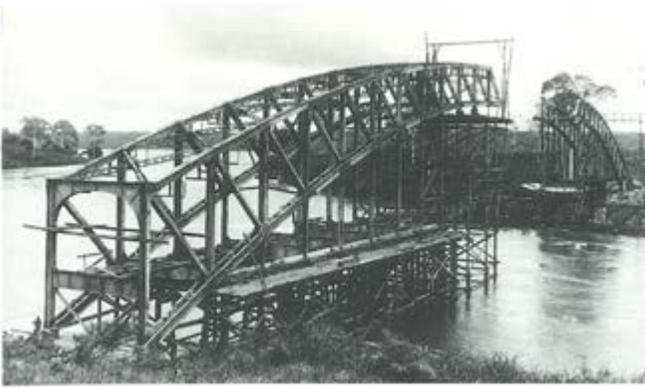
*Brückenbau in Kamerun. In der damals deutschen Kolonie leitete Ludwig Kühne von 1910 bis 1912 den Bau der Fachwerkbogenbrücke über den Fluß Sanaga bei Edea für die Eisenbahn von der Küste ins Landesinnere nach Jaunde.*
