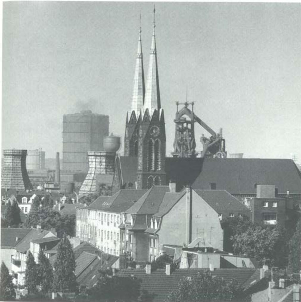
zeugung des verlangten Gasdrucks von 340 kg/qm hat die auf dem Gas schwimmende Abschlussscheibe ein Gesamtgewicht von 1200 t.
