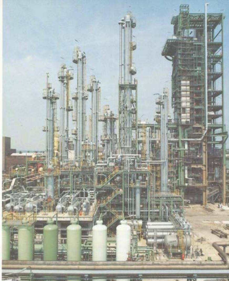
*Synthesegasanlage Ruhr; rechts Vergasungsteil, Mitte Gasreinigung.*
