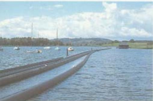
*Polyethylenrohre „vor Ort“ gefertigt, sorgen für einen sauberen Chiemsee (oben). Rohrfertigung aus Polyethylen bei der Tochtergesellschaft Europlast (rechts).*
