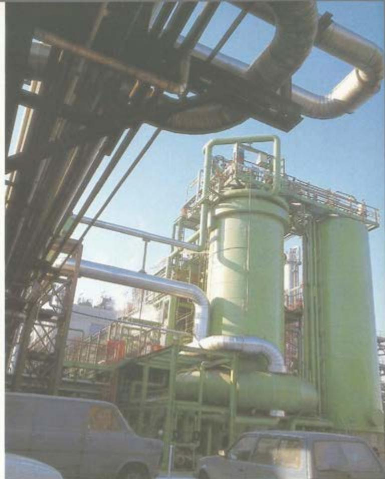
Teilansicht der neuen Oxoanlage zur Hydroformylierung von Propylen.
