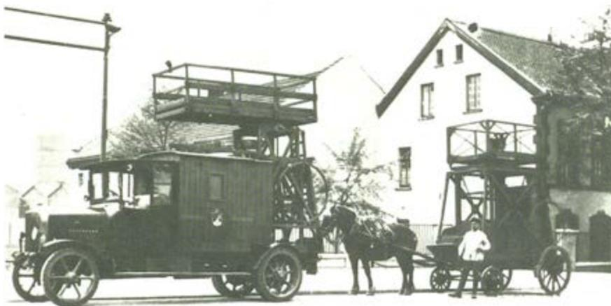
*Der technische Fortschritt bei der Unterhaltung der Oberleitung wird auf dem oberen Bild aus dem Anfang der 20er Jahre demonstriert: Die von einem Pferd gezogene Arbeitsbühne wurde damals durch einen motorisierten Montagewagen ersetzt. – Wie das untere Bild zeigt, gab es auch schon in den 20er Jahren Verkehrssicherheitsaktionen. In Sütterlinschrift mahnen Spruchbänder an dem ersten Straßenbahnwagen: „Warte, bis der Wagen hält!“ und „Springe nicht auf während der Fahrt!“.*
