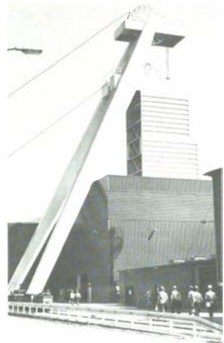
*Neues Sterkrader Wahrzeichen: der am 3. Juni 1985 in Betrieb genommene supermoderne, von der GHH Sterkrade gelieferte 42 m hohe Förderturm an der von-Trotha-Straße. In den Ausbau von Schacht II der Zeche Sterkrade wurden 36 Millionen DM investiert. Unten: die Fördermaschine auf Zeche Sterkrade.*
