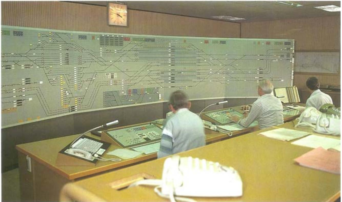
terer Bauart ersetzt, von der neuen Anlage aus werden der Bahnhof Buschhausen (nur noch Güterverkehr) und der Reisezugverkehr im Bahnhof Essen-Frintrop ferngesteuert. Noch einige interessante Zahlen: Im Bahnhofs- bzw. Stellwerksbereich liegen 42,5 km Hauptgleise mit Streckenverbindungen und 11 km Abstellgleise. Per Knopfdruck werden 214 Weichen „ferngestellt“, 60 Vor- und 63 Hauptsignale betätigt.
