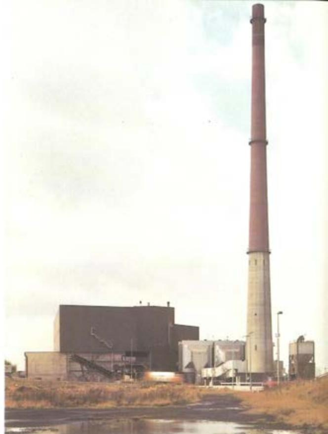
kohlestaubgefeuerten Lufterhitzer die wirtschaftlichste Lösung darstellen würde. Ausschlaggebend war auf der einen Seite das breite einsetzbare Brennstoffband von Kohle, Öl und Gas, auf der anderen Seite die hohe Temperatur der anfallenden Abwärme, die ohne wesentliche Einbuße an elektrischer Leistung für die Fernwärme genutzt werden kann.
