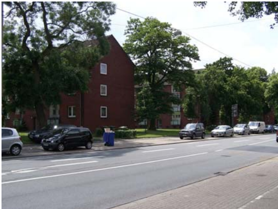
Duisburger Straße: Wohnbebauung an Einmündung Leopoldstraße (Potenzial für Loggienverglasung)
